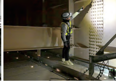
桁内部点検作業の様子
