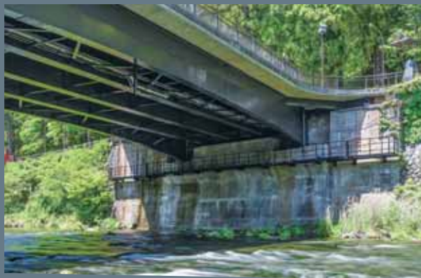
日光橋 施主：栃木県日光土木事務所 場所：栃木県日光市
