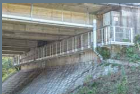
名神林田第二高架橋 施主：中日本高速道路株式会社 場所：滋賀県東近江市
