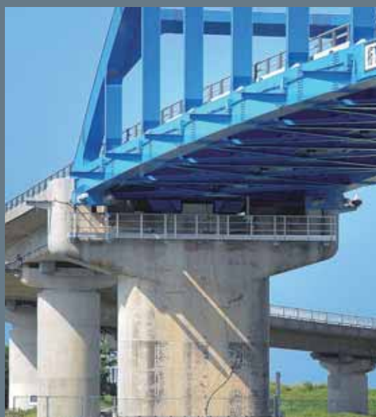
サザンゲートブリッジ 施主：石垣市役所 場所：沖縄県石垣市
