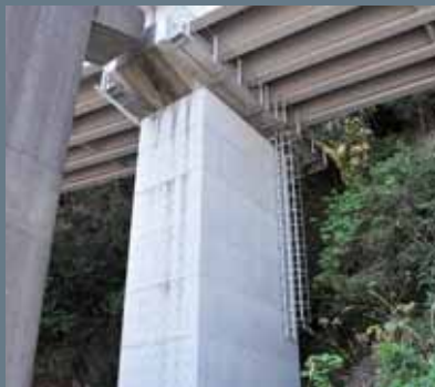
夕吹高架橋検査路 施主：静岡県熱海土木事務所 伊東支所 場所：静岡県伊東市
