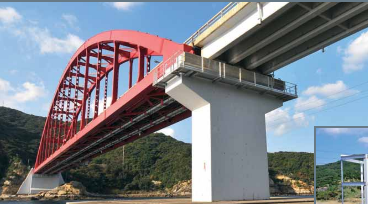
頭ヶ島大橋 施主：五島振興局上五島支所 場所：長崎県南松浦郡
