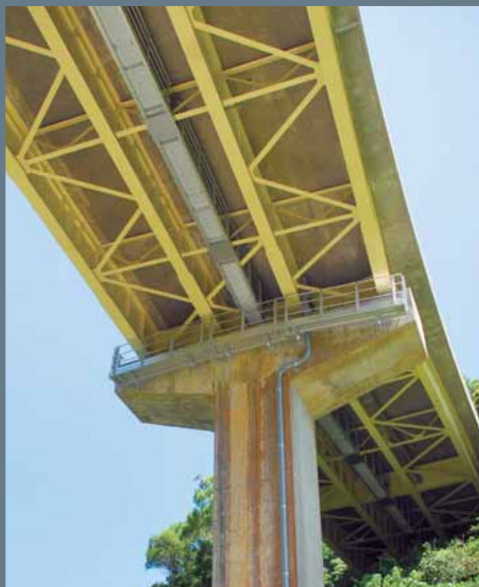
たまた橋 施主：沖縄県北部土木事務所 場所：沖縄県国頭郡
