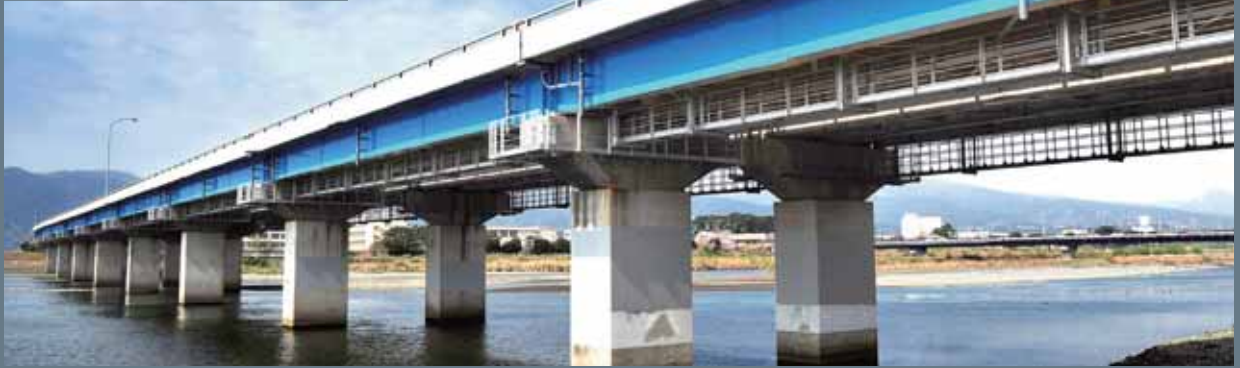
夕吹高架橋検査路 施主：静岡県熱海土木事務所 伊東支所 場所：静岡県伊東市
