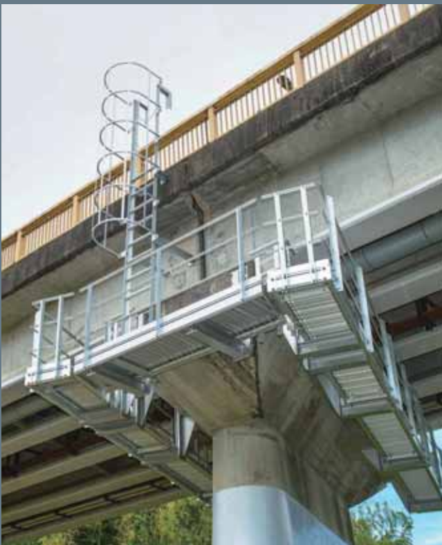
中橋 施主：群馬県安中土木事務所 場所：群馬県安中市
