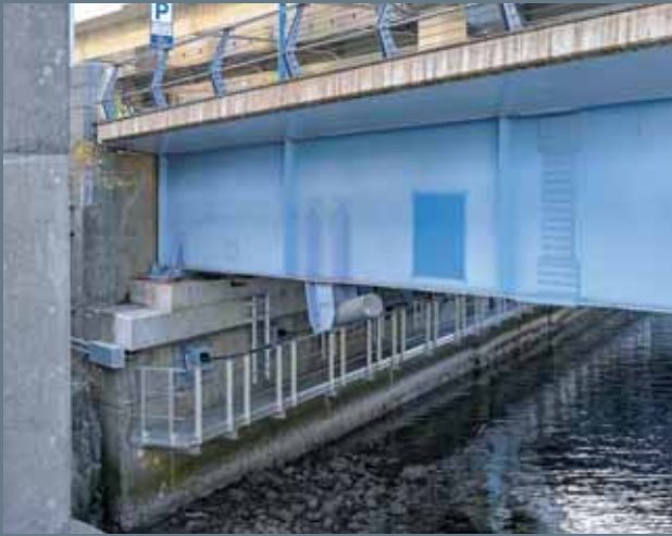
天王洲大橋 施主：東京都第一建設事務所 場所：東京都品川区
