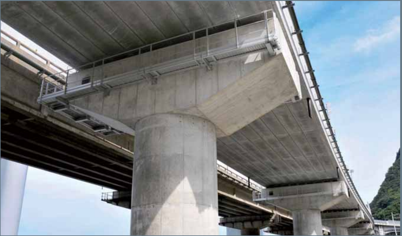
歌高架橋 施主：国土交通省北陸地方整備局 高田河川国道事務所 場所：新潟県糸魚川市
