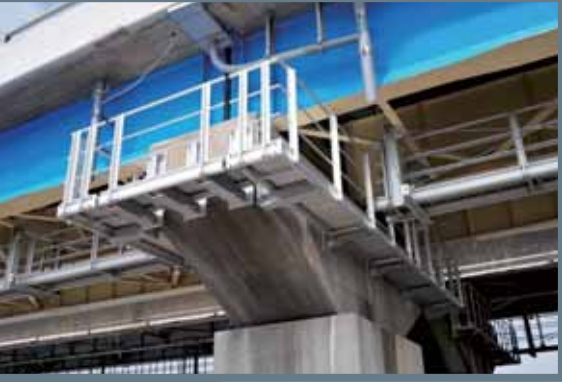
西湘大橋 施主：中日本高速道路株式会社 場所：神奈川県小田原市
