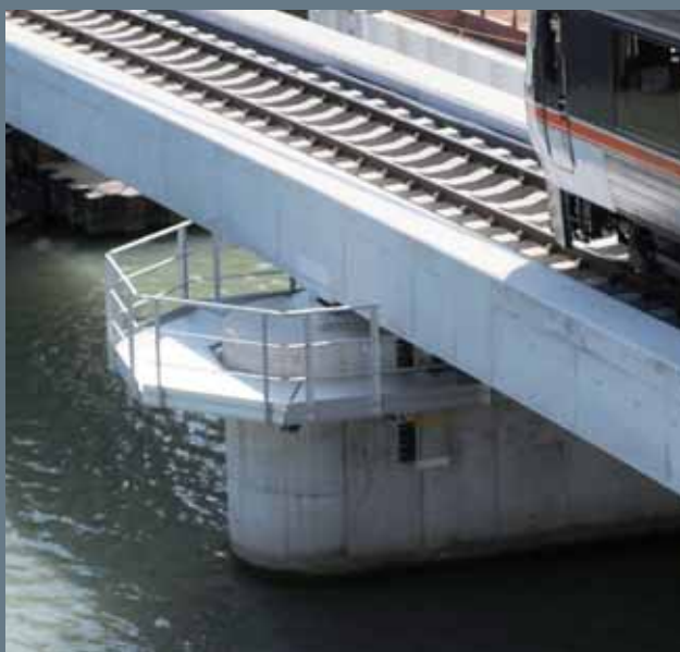
那智川橋りょう 施主：西日本旅客鉄道株式会社 場所：和歌山県那智勝浦町
