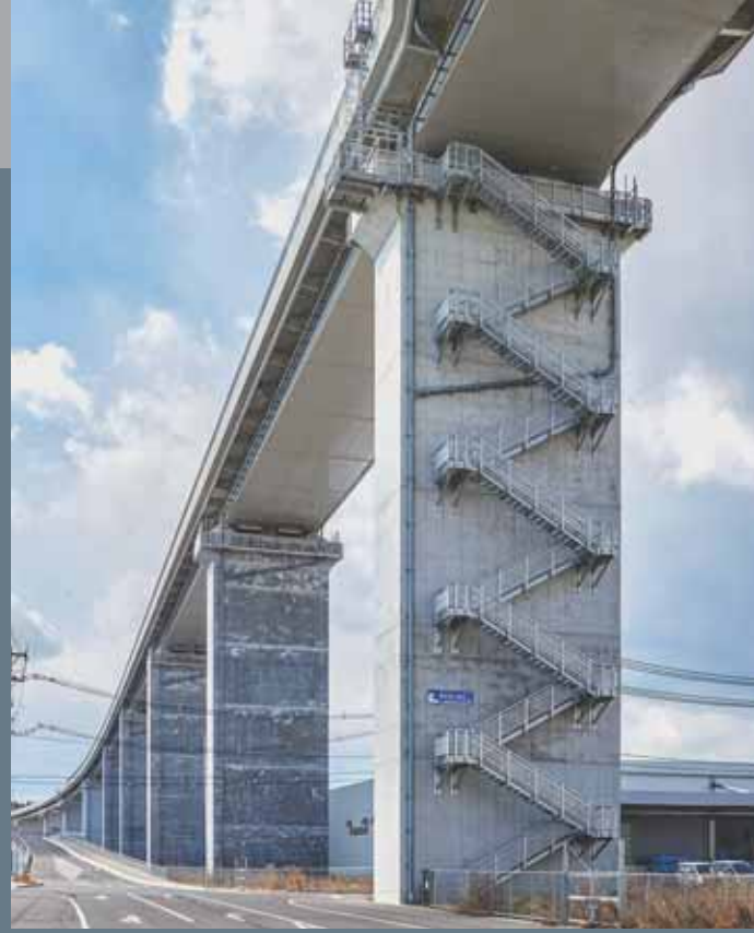
気仙沼湾横断橋（川口地区） 施主：国土交通省東北地方整備局 仙台河川国道事務所 場所：宮城県気仙沼市
