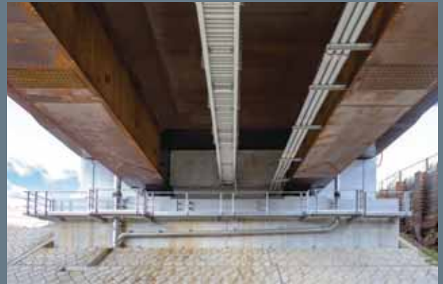
龍ヶ鼻橋 施主：群馬県吾妻振興局 中之条土木事務所 場所：群馬県吾妻郡
