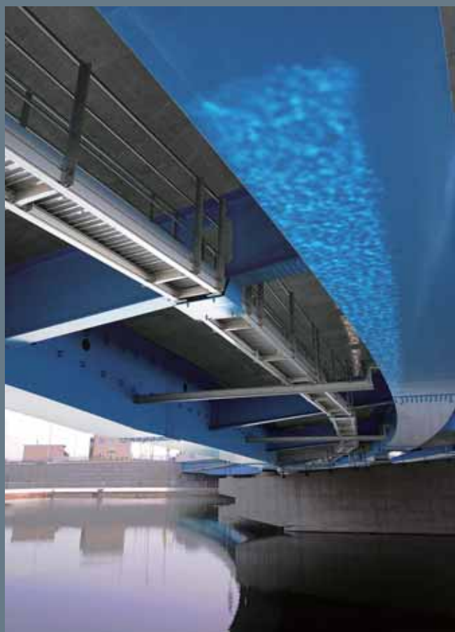
佐保川橋 施主：西日本高速道路株式会社 場所：奈良県大和郡山市
