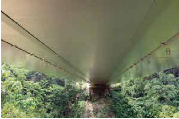
ヒチャンガーラ橋／沖縄県 新設橋に設置
