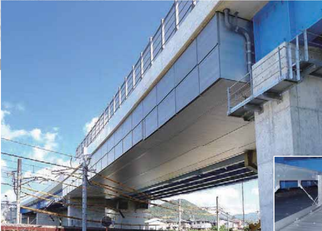
小熊高架橋 II 期線 / 和歌山県 新設橋に設置
