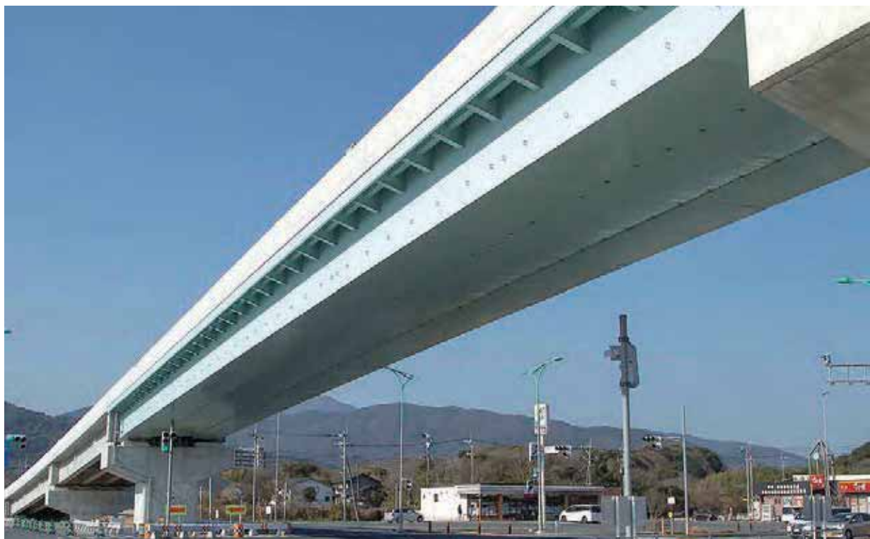
北九州空港線 4 号橋 / 福岡県 新設橋に設置
