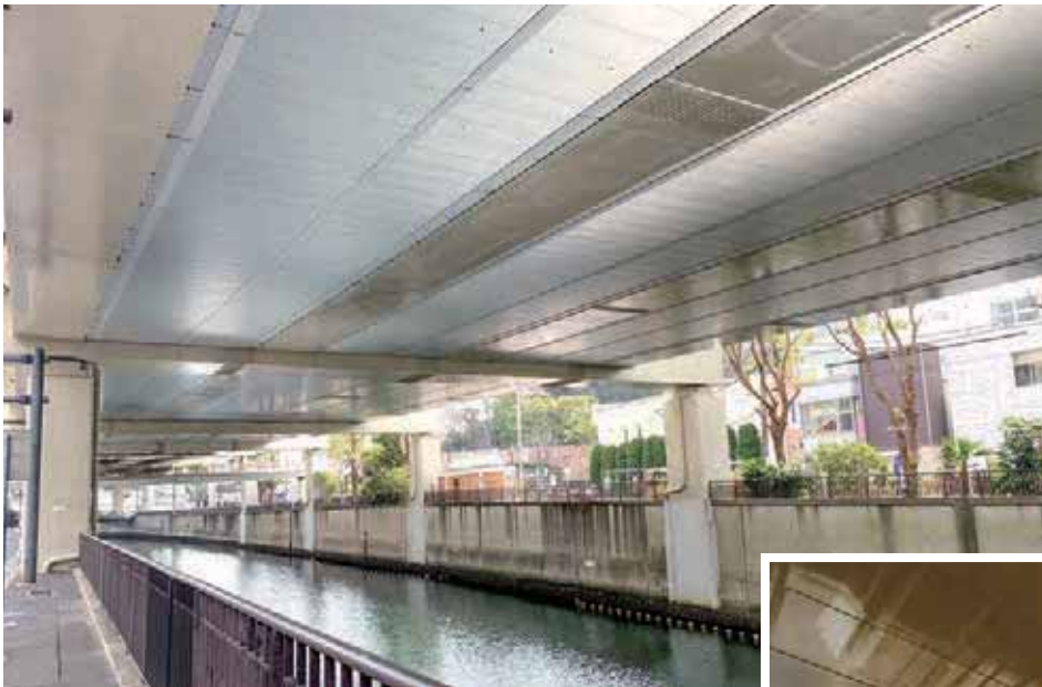
神奈川3号狩場線／神奈川県 既設橋に設置
