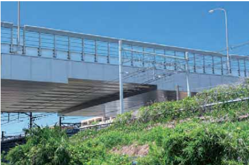
法泉高架橋／神奈川県 既設橋に設置
