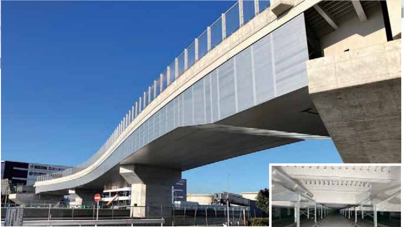
東扇島水江町線高架橋／神奈川県 新設橋に設置
