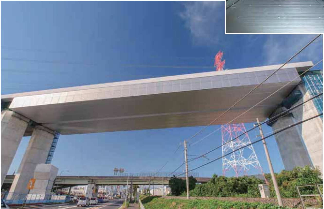
城陽第一高架橋／京都府 新設橋に設置
