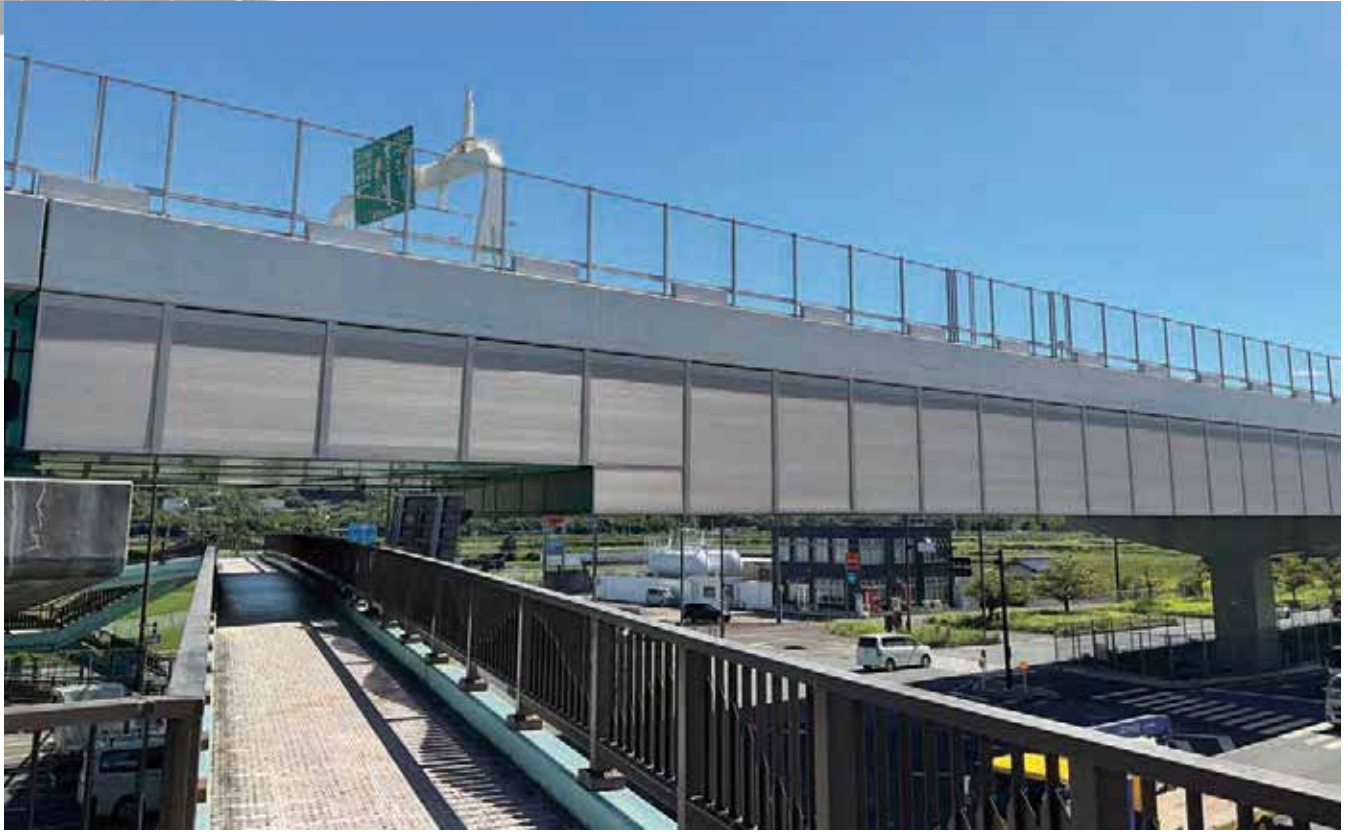
福北高速環状線（月隈～金の隈）／福岡県 既設橋に設置
