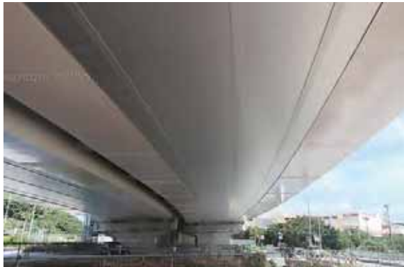
北丘高架橋（下り）／沖縄県 新設橋に設置
