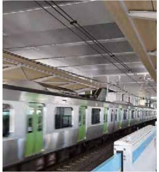
高輪ゲートウェイ駅／東京都 新設橋に設置
