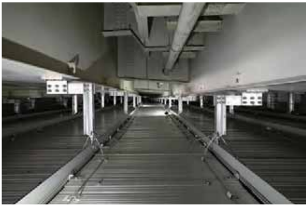
11号台場線（ゆりかもめ）／東京都 既設橋に設置
