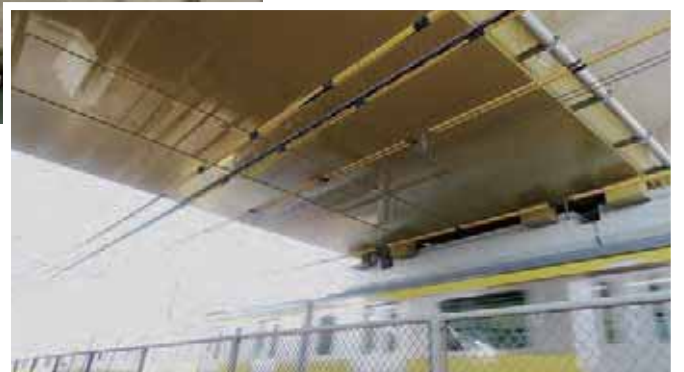
小松橋／東京都 既設橋に設置
