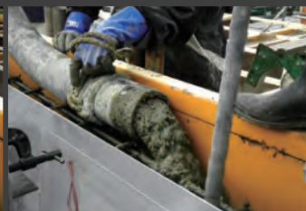
●コンクリート充填
