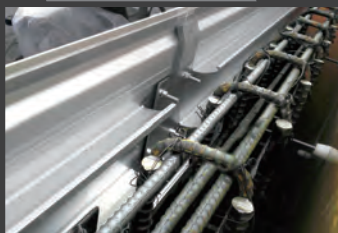
●残存型枠と配筋の状況
