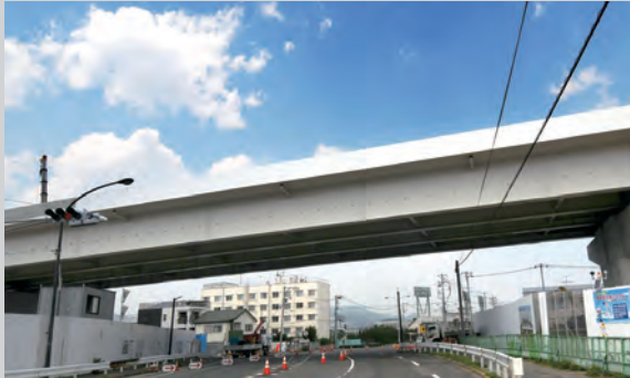
高速3号線Ⅲ期鋼上部工（観音西 工区）型枠：広島県
