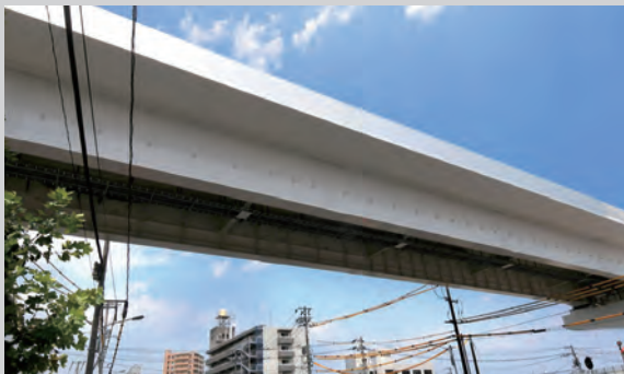
高速3号線Ⅲ期鋼上部工（江波東 P127-133）型枠：広島県
