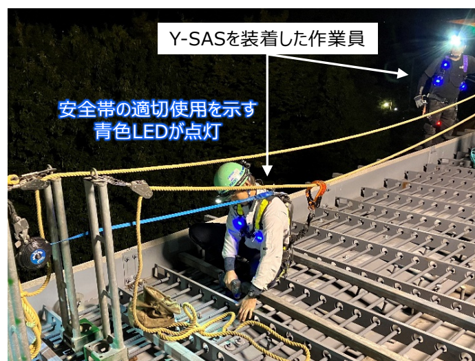
鋼橋架設現場での Y-SAS 使用状況
