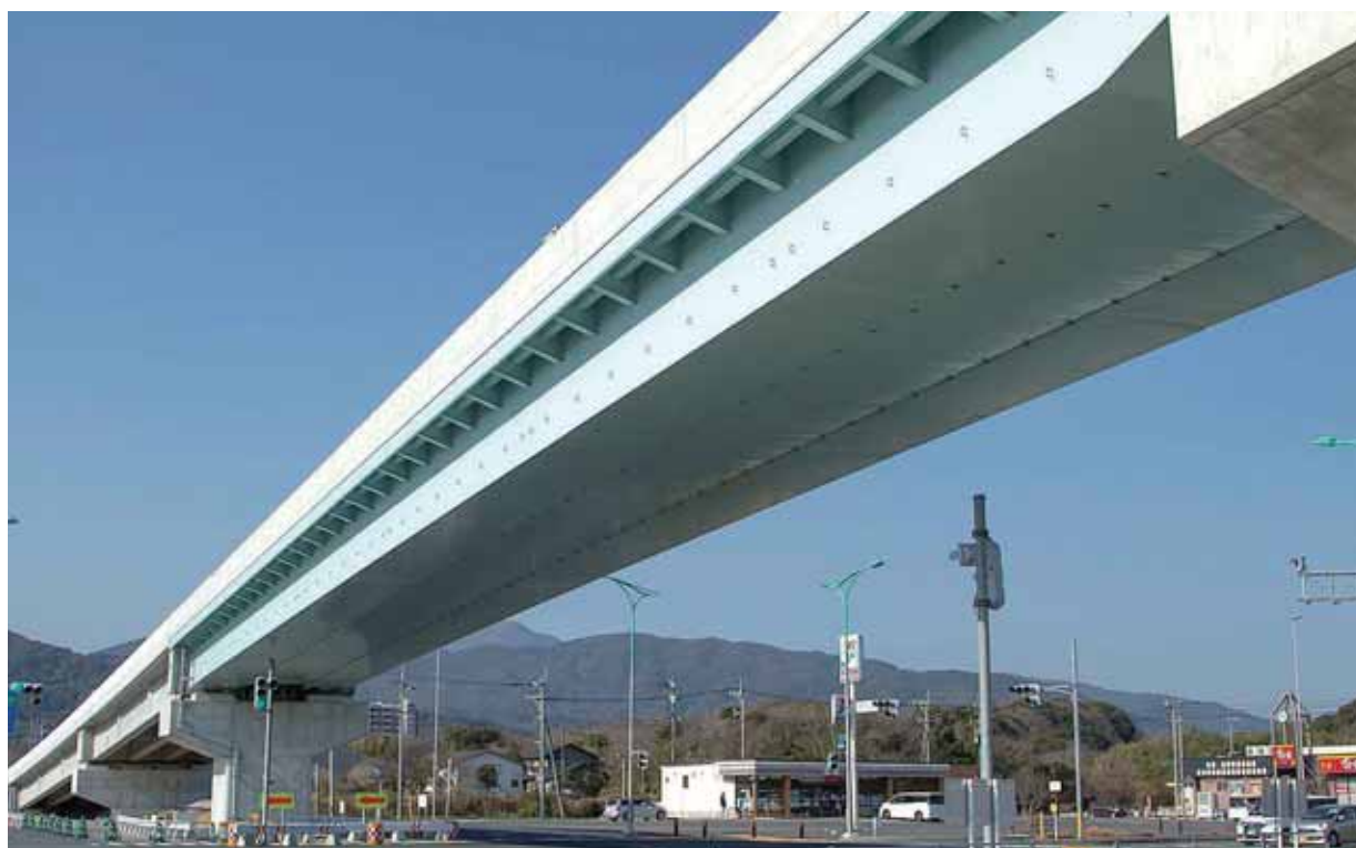
北九州空港線 4 号橋／福岡県 新設橋に設置
