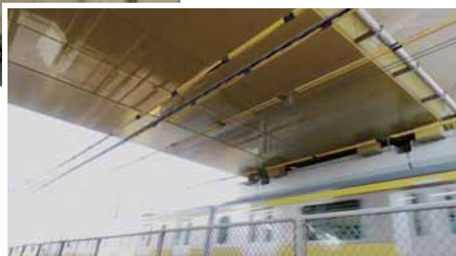
小松橋／東京都 既設橋に設置
