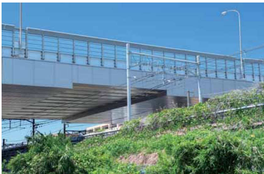
法泉高架橋／神奈川県 既設橋に設置
