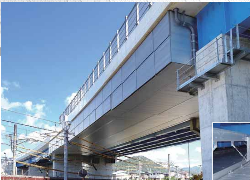
小熊高架橋Ⅱ期線／和歌山県 新設橋に設置
