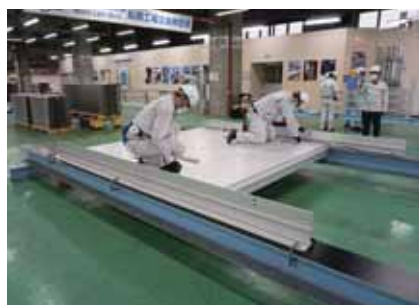
設置（ボルト締め付け）
