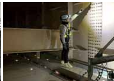
桁内部点検作業の様子
