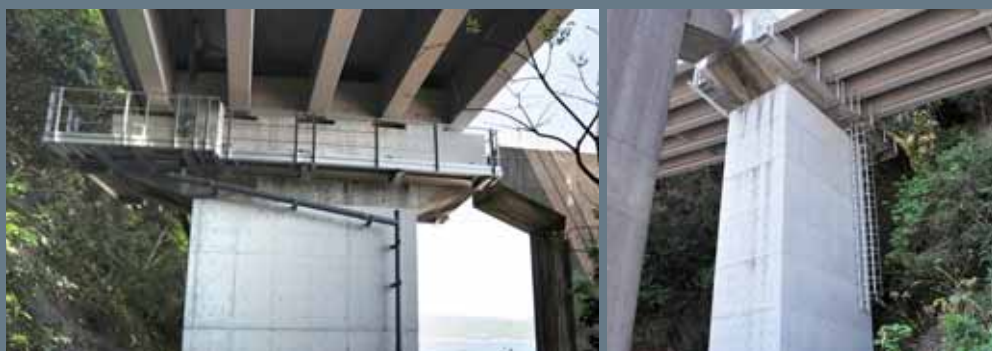
汐吹高架橋検査路 施主：静岡県熱海土木事務所 伊東支所 場所：静岡県伊東市
