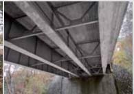
「金慶橋」は、1961年(昭和36年)6月に本 邦初の全溶接アルミニウム橋梁として、芦屋―有 馬間有料道路に架橋されました。橋桁部は、アル ミニウム合金の高耐食性が発揮され、健全な状態 が維持されています。
