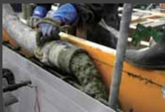
●コンクリート充填
