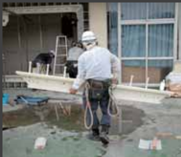
軽さを活かした施工事例 アルミ合金製耐震ブレースの場合
