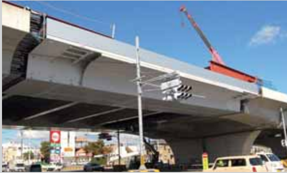
街路工事徳島東環状末広・住吉 高架橋：徳島県
