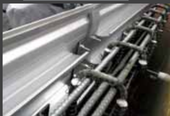
●残存型枠と配筋の状況
