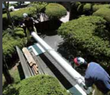
狭小地など大型重機の入らない場所におけるアルミ合金製耐震ブレースは、軽量がゆへの操作性の良さから、数多くのご採用をいただいております。
