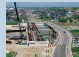
橋梁架け替え用の迂回路として
