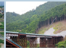
橋梁架け替え用の迂回路として
