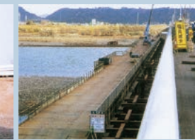
重機作業用の仮橋として
