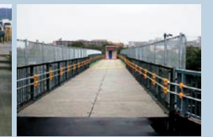
歩道用の仮橋として
