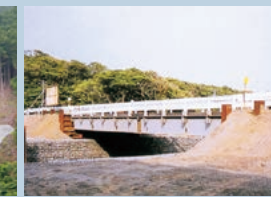
災害時の応急橋として
